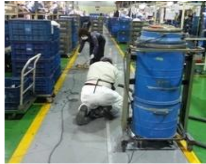
컷팅작업 (콘크리트 컷팅, 건식)
