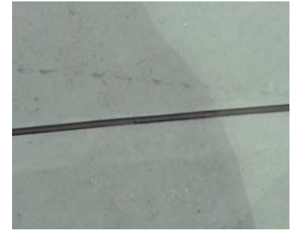
Magnetic Bar 삽입 (폭 6mm, 깊이 10mm)
